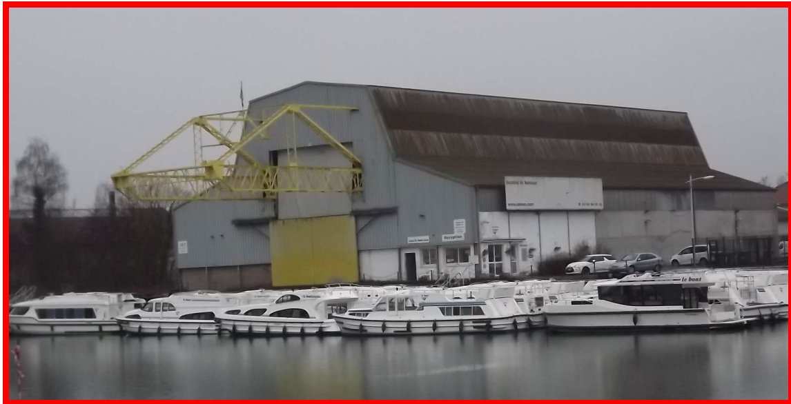
La base de location de bateaux de plaisance en janvier 2017
