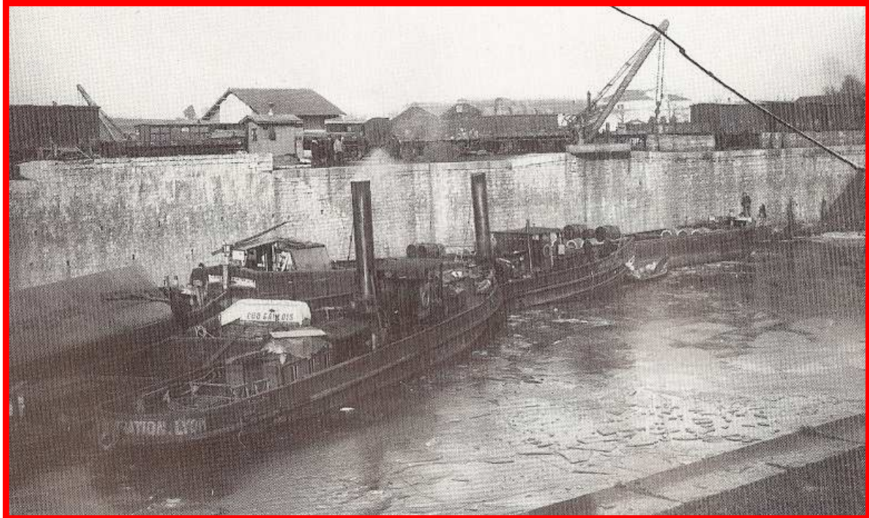
La gare d'eau et ses grues de levage.
