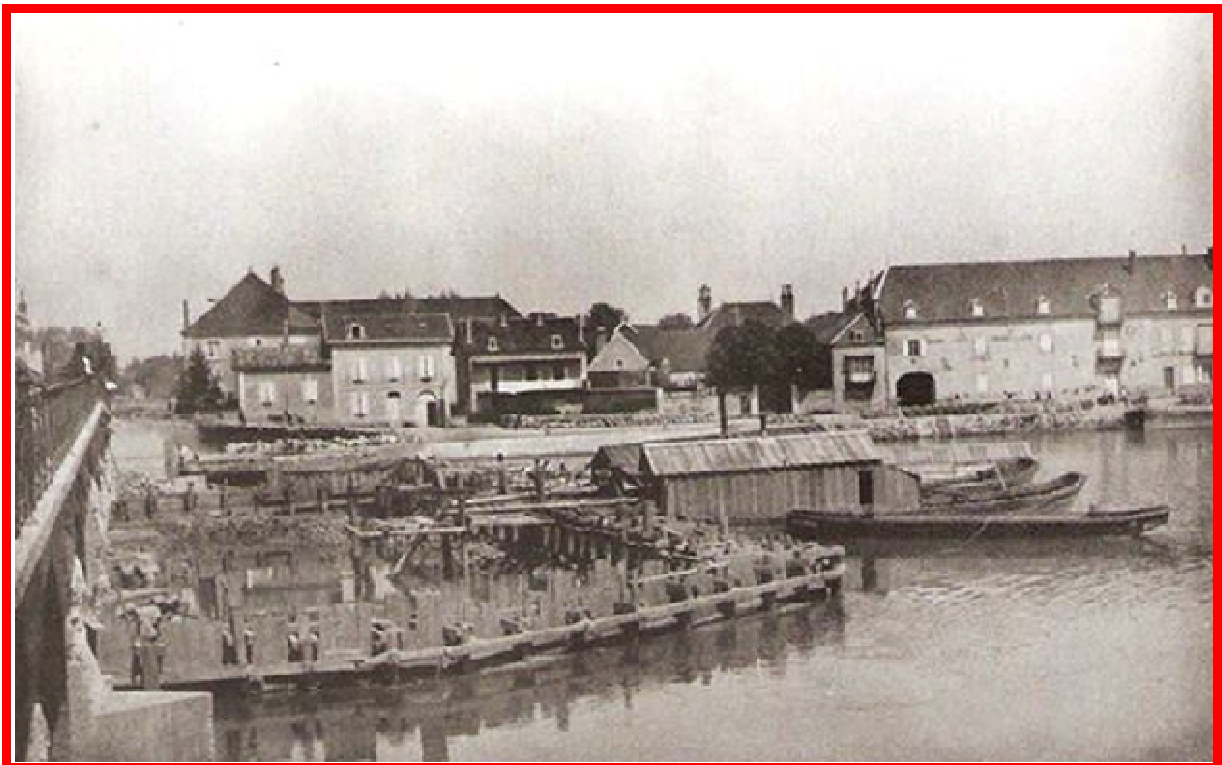
Travaux d'élargissement du pont 1889
