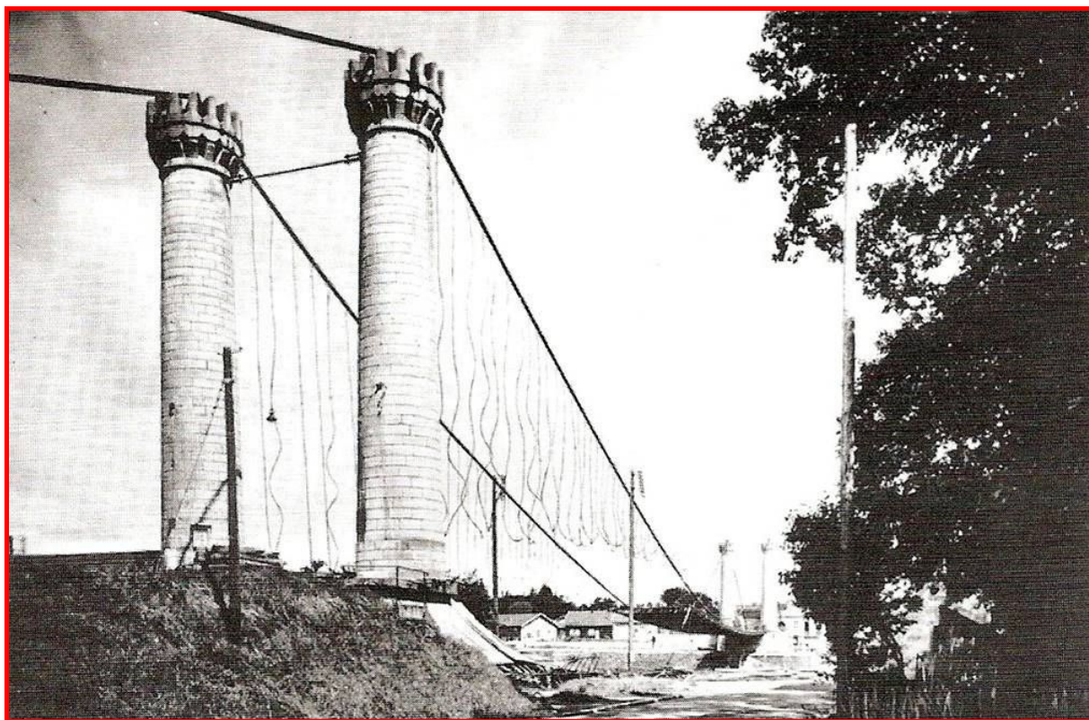
Une partie du pont détruit : Ce qu'il reste du tablier et les filins qui pendent.
