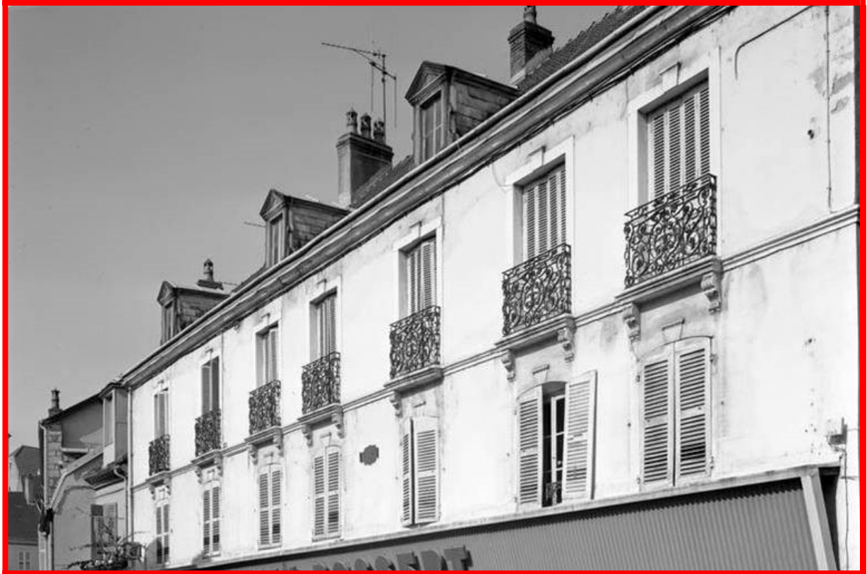
Façade antérieure dans les années 1980.
