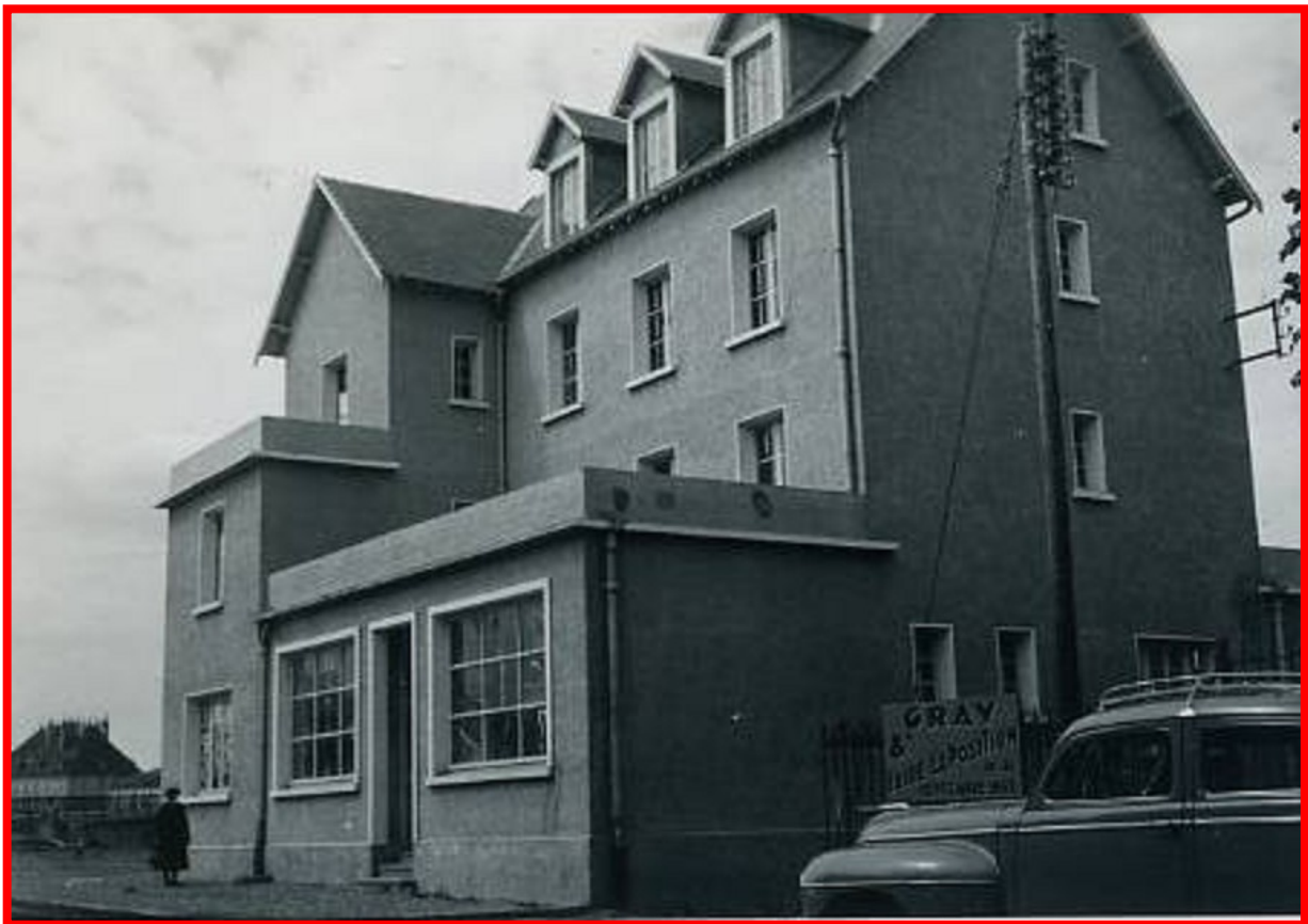
Hôtel Bellevue en 1952 construit sur les ruines de 1940.
