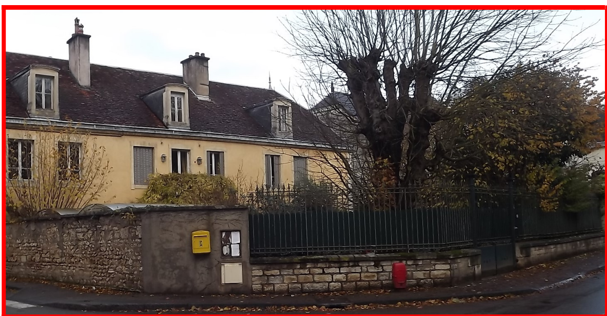
Le bâtiment en 2019
